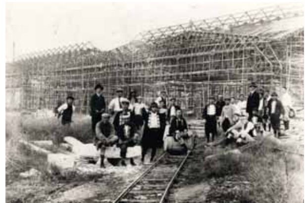
格納庫の組立て風景。工事は広島森田組他が当たっている。(写真は、立川市のHPより)
