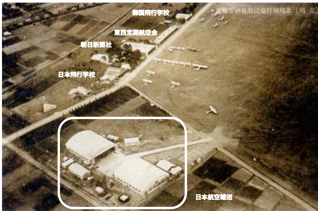
飛行場南西端の民間格納庫群。日本航空輸送の格納庫は昭和 4 年 6 月竣工なので、それ以降の撮影である（当時の絵葉書より）
