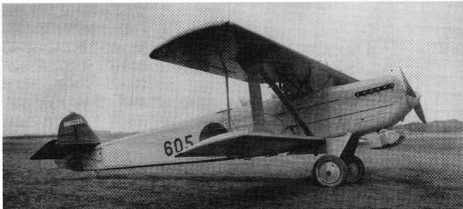
【写真1-5】 飛行第五連隊の八八式偵察機二型の605号機(当時の絵葉書から)。垂直安定板と方向舵が塗られているが、本来の部隊標識は方向舵と昇降舵だけであり、記念塗装的に垂直安定板も塗られているのだろう。なお、飛行第五連隊に配備された八八式偵察機は二型のみと判明しており、この605号機は北に隣接する石川島飛行機製作所製である。
